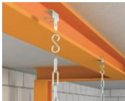
Монтаж балочного зажима Монтаж балочных зажимов и подвесной цепи для установки светильников.
