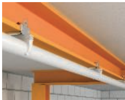
Монтаж балочного зажима Монтаж балочных зажимов и монтажной трубы параллельно балке.
