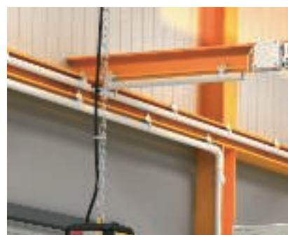
Монтаж балочных зажимов Балочный зажим можно закрепить на фланец как в горизонтальном так и вертикальном положении.
