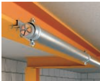
Монтаж балочного зажима Монтаж балочных зажимов с резьбой и дистанционной скобой 732 для крепления инсталляционных труб.
