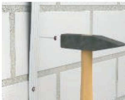
Применение стального гвоздя Imtri Гвоздь Imtri вбивается в промежутки между перемычками плоского провода.
