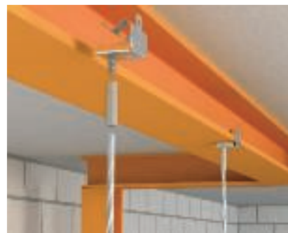
Монтаж балочного зажима Монтаж балочных зажимов и крепления резьбовых стержней с соединительной муфтой.
