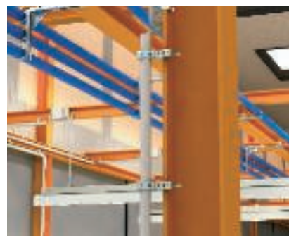
Балочный зажим для труб Использование винтовых балочных зажимов с непосредственным креплением труб.
